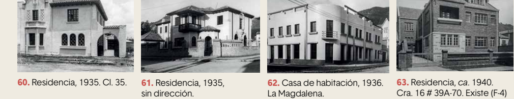
60. Residencia, 1935. Cl. 35 61. Residencia, 1935, sin dirección 62. Casa de habitación, 1936. La Magdalena. 63. Residencia, ca. 1940. Cra. 16 # 39A-70. Existe (F-4)
