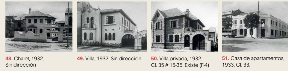
48. Chalet, 1932. Sin dirección 49. Villa, 1932. Sin dirección 50. Villa privada, 1932. Cl. 35 # 15-35. Existe (F-4) 51. Casa de apartamentos, 1933. Cl. 33
