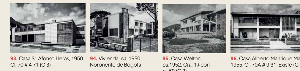
93. Casa Sr. Alfonso Uleras, 1950. Cl. 70 # 4-71 (C-3) 94. Vivienda, ca. 1950. Nororiental de Bogotá 95. Casa Welton, ca. 1952. Cra. 1ª con cl. 69 (C-2) 96. Casa Alberto Manrique Martín, 1955. Cl. 70A # 9-31. Existe (C-3)
